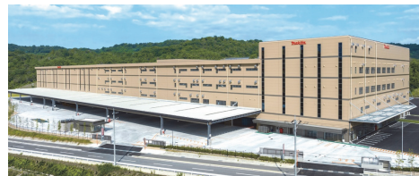
岡山物流センター (支店・営業所併設)
