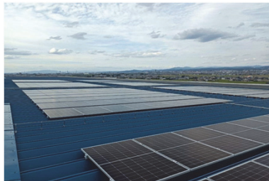
岡崎工場 物流棟
