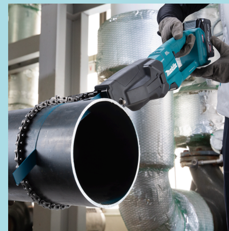
プラント建設
