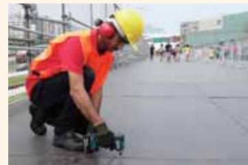
▲マキタ充電式インパクトドライバを使用して歩道に木板を取り付け
