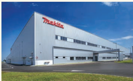
▲完成した第4期棟
