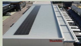
岐阜支店の太陽光パネル
