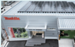
鹿児島営業所の太陽光パネル
