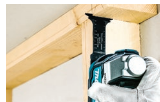
2 外枠調整の面一切断
