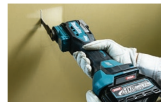
1 石こうボードの切断
