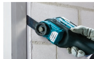
7 弾性シーリング除去作業
