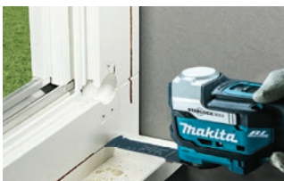
4 窓枠の取り外し
