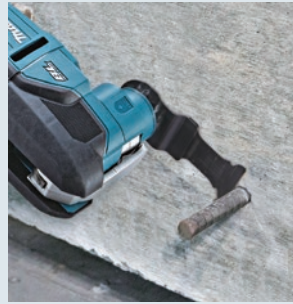
鉄筋の面一切断
