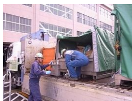
■高濃度PCB廃棄物処理
