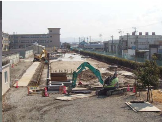
■貯留槽工事風景
