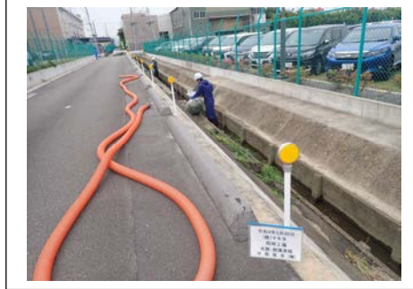
■岡崎工場:用水路清掃風景 (2021年5月)
